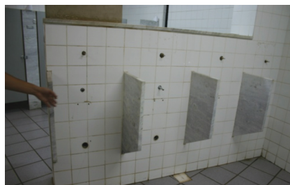
Terminal Asa Sul - mictório destruído em banheiro
