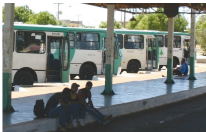
Terminal Setor P Norte - falta de bancos
