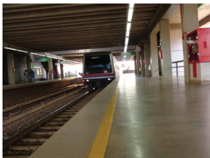
Estação Concessionárias – ausência de sinalização para portadores de necessidades especiais
