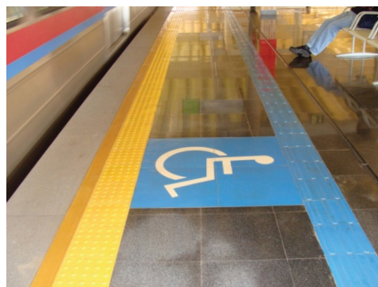
Estação Ceilândia Norte - plataforma sinalizada para portadores de necessidades especiais
