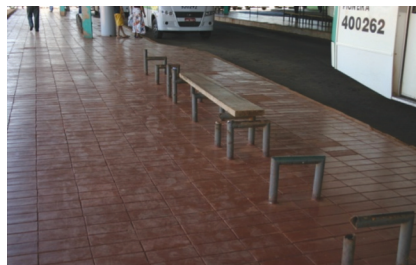
Terminal Setor O - bancos sem manutenção
